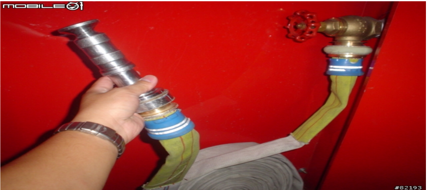
水帶的公接頭..插進瞄子的母接頭
